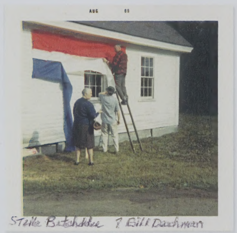
Ellsworth Town House (August 1969)
